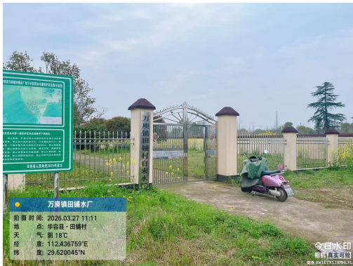
万庾镇田铺水厂现状
