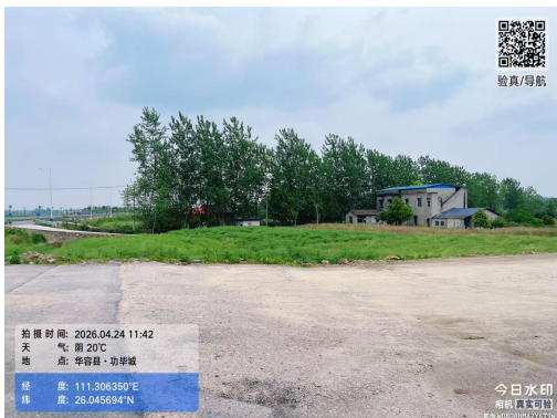
禹山镇中途加压调节池现状
